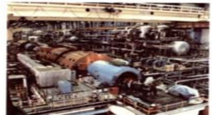
VI.8. ábra. A Paksi Atomerőmű turbinacsarnoka turbinákkal és generátorokkal
