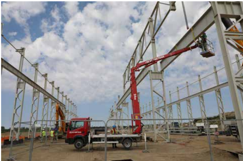
Épülnek az acél- és betonacél-összeszerelő komplexum épületei
