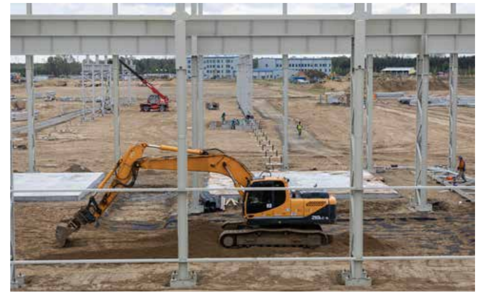
Dolgoznak a munkagépek az építési-szerelési bázison
