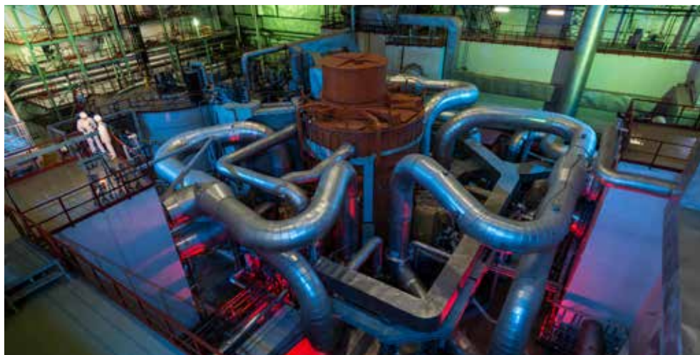
Az orosz BN-800 típusú gyorsneutronos blokk
