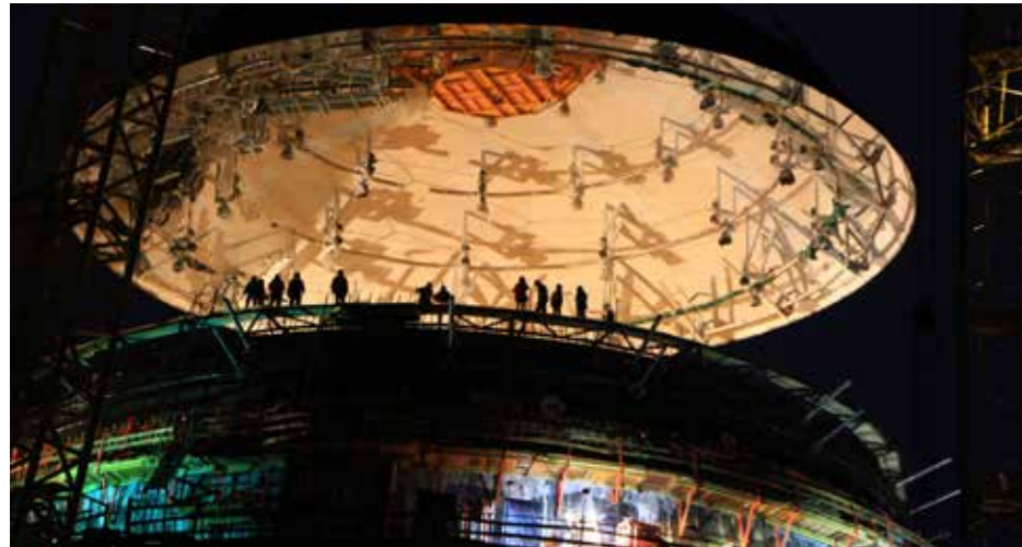
Pillanatkép a Belorusz Atomerőmű építéséről (2017-es kép) Forrás: Roszatom
