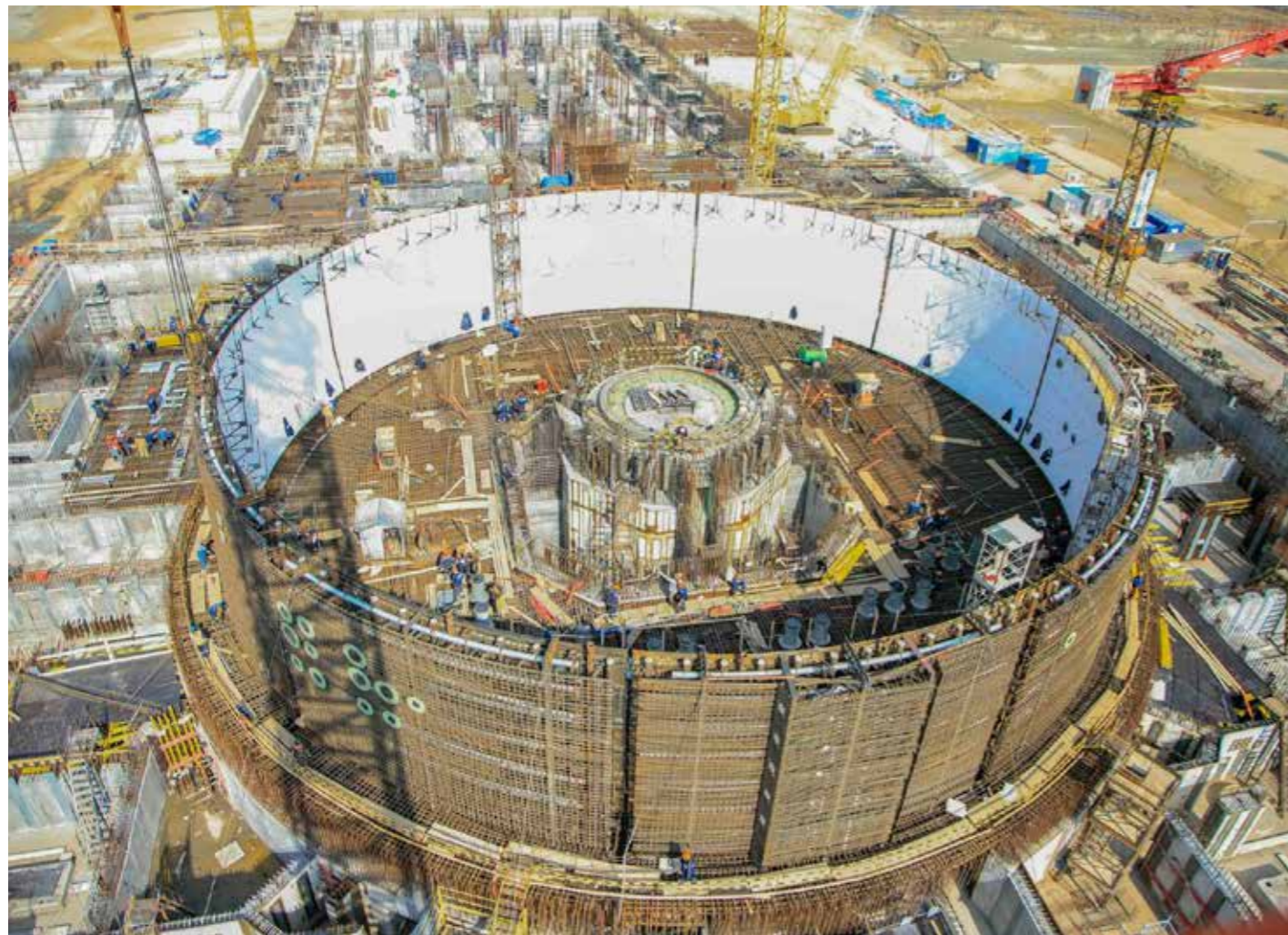
Az épülő VVER-TOI típusú blokk fotó: Roszatom
