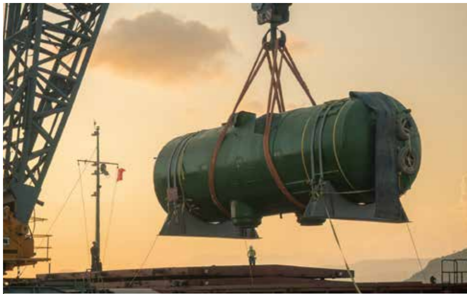
Törökország is az atomenergia mellett teszi le a voksát. Október elején megérkezett az építési területre az Akkuyu Atomerőmű első blokkja számára gyártott négy orosz gőzfejlesztő Kép: Roszatom
