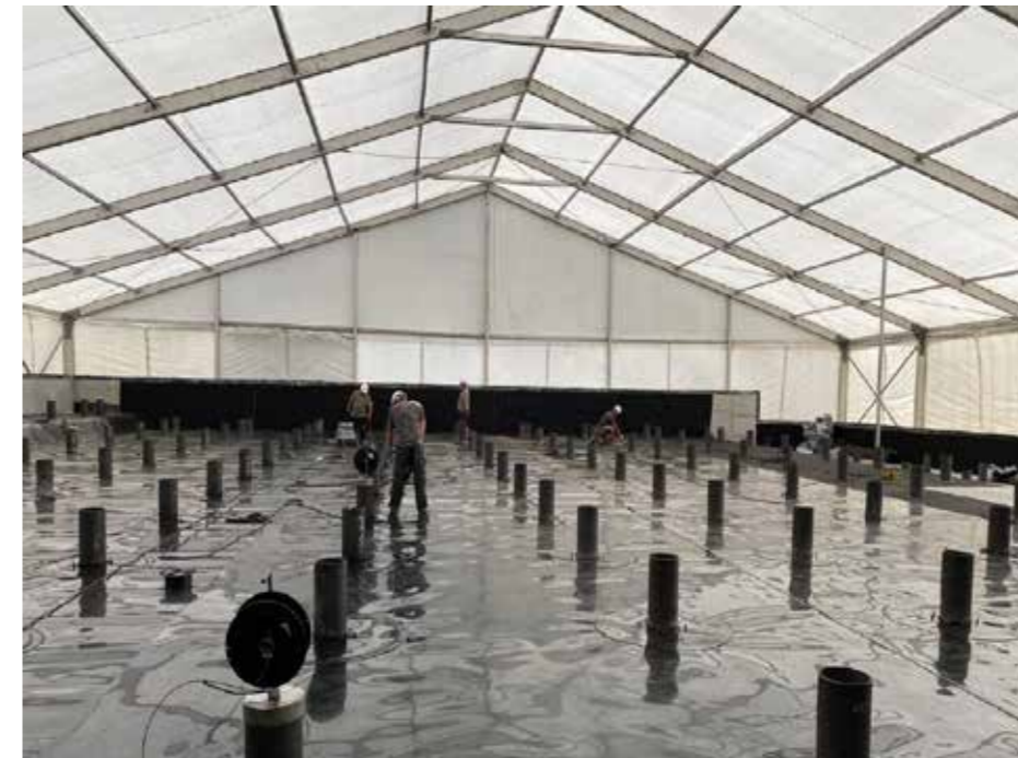
A KKÁT-nak eddig hat modulja készült el, a hetedik építés alatt van. Az utolsó elkészült modulban 1 364 tonna acélszerkezetet és 857 tonna betonacélt építettek be.
