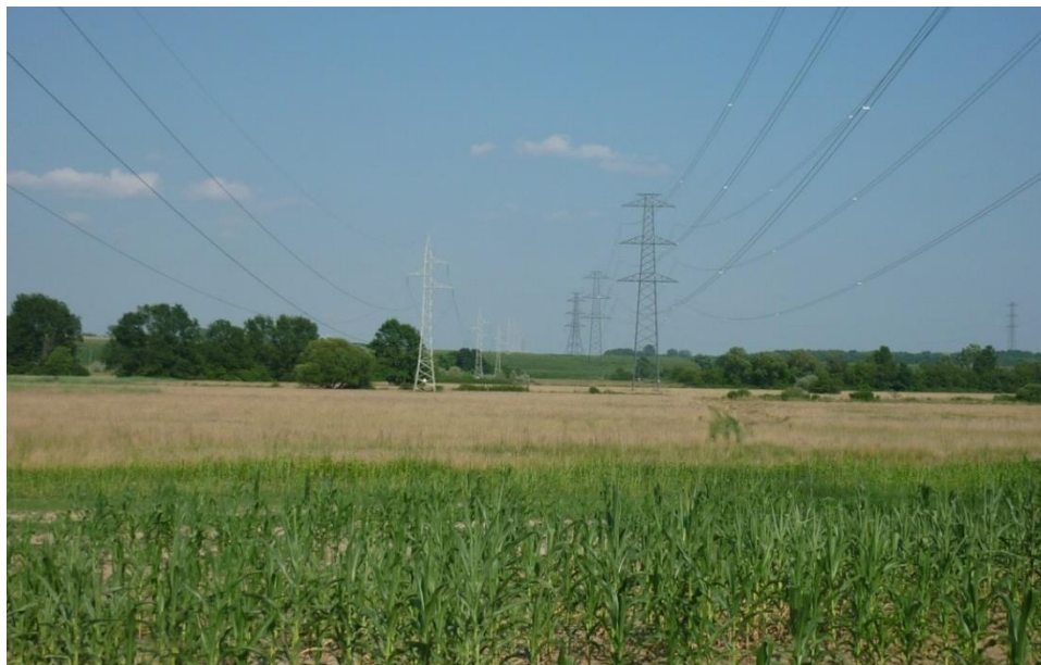
7.3.2-4. ábra: Pécs-Országhatár 400 kV-os szabadvezeték FENYŐ típusú oszlopokkal, vezetékfolyosó
