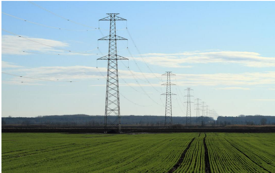
7.3.2-3. ábra: Martonvásár-Győr 400 kV-os szabadvezeték FENYŐ típusú oszlopokkal
