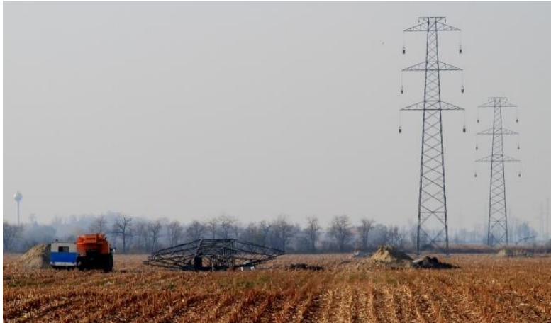
7.3.5-1. ábra: Martonvásár-Győr 400 kV-os szabadvezeték, oszlopszerelés területigénye
